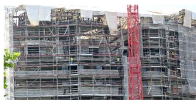
Operai al lavoro su una facciata ricoperta da un ponteggio
