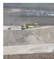
Un cantiere per la Tava a Sona
