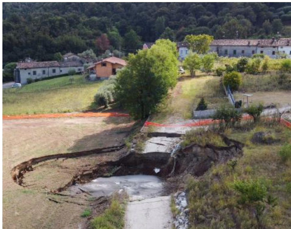
La voragine Il cedimento del suolo in territorio bresciano nell'area di un cantiere della Tav
